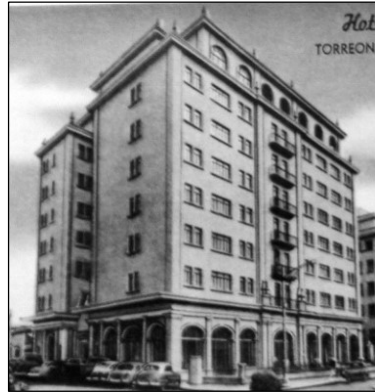
Edificio del hotel Elvira
